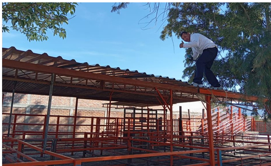
Imagen 17 "Instalación de báscula, instalación de tejaban y pintura en la báscula del rastro municipal"
