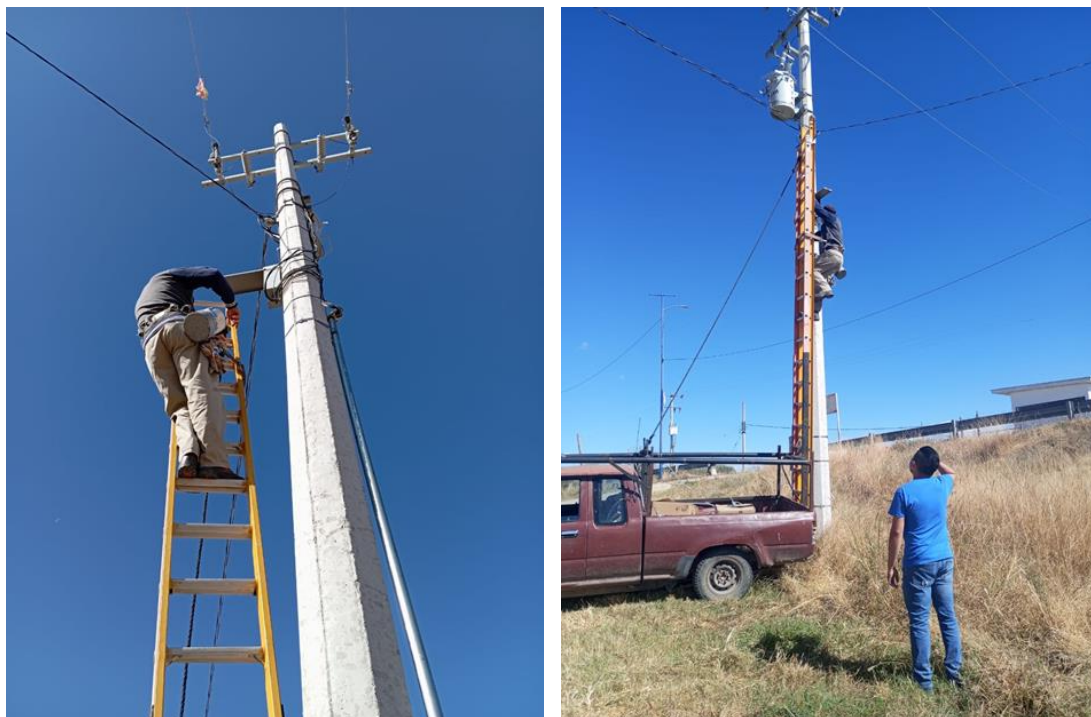
Imagen 14.3 y 14.4 "Mantenimiento correctivo a las luminarias en la presa "Miguel Alemán".
