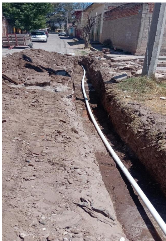
Imagen 11.2 “Ampliación de red de agua en la calle Prolongación Libertad”
