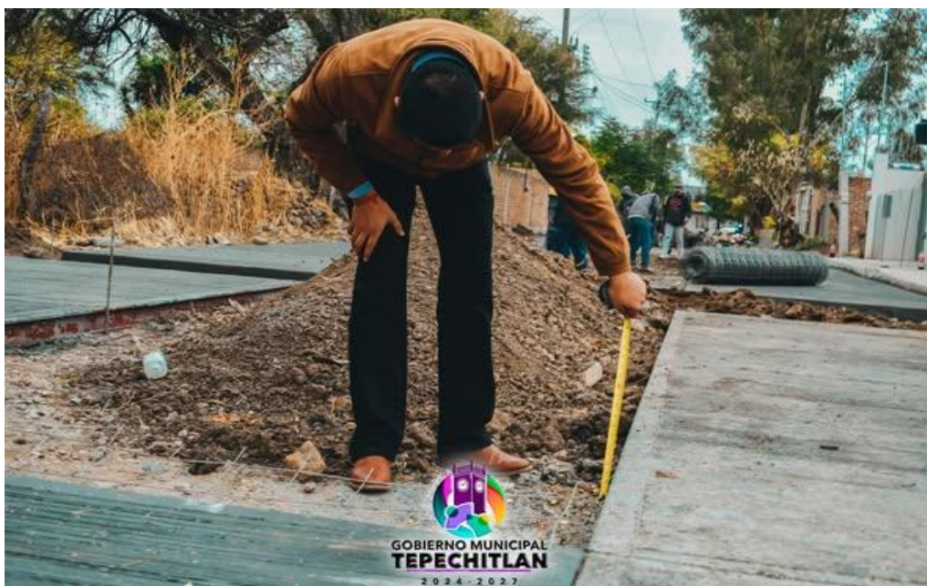
Imagen 4 “Seguimiento técnico de la obra realizada en la localidad del Terrero”
