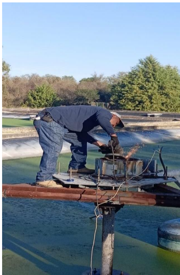
Imagen 12 y 12.1 "Instalación de aireador"
