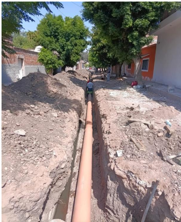
Imagen 13 y 13.1 "Instalación de tubería de 8" para drenaje en calle Abasolo "
