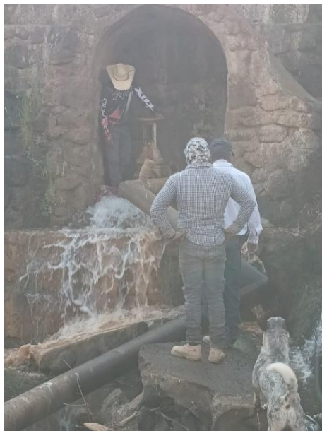
Imagen 10 “Limpieza tubería de la presa “los mapaches”
