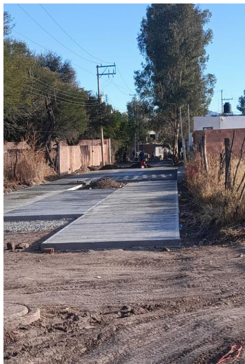
Imagen 1.1 "Pavimentación en el Terrero"
