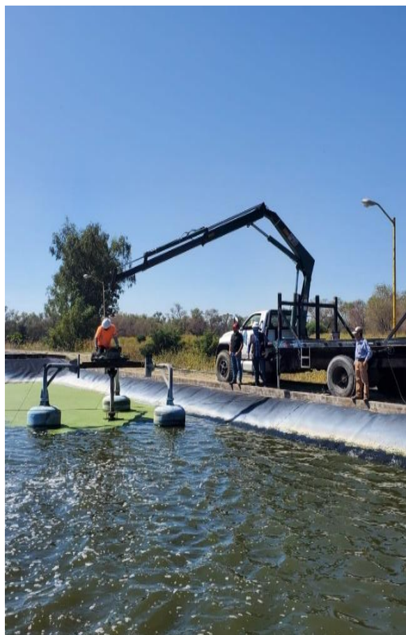
Imagen 12 y 12.1 "Instalación de aireador"
