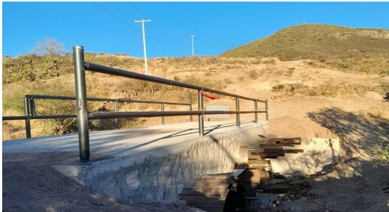
Imagen 5.3 "Terminación del puente vehicular en la comunidad de San Pedro Ocotlán"
