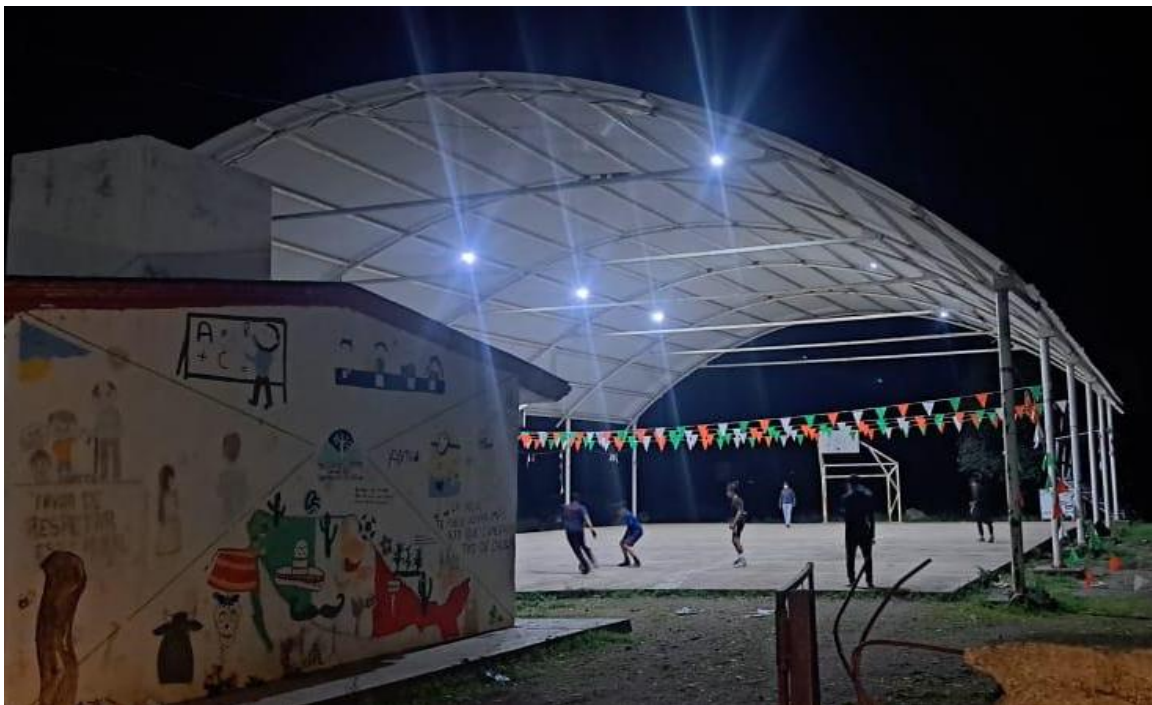
Imagen 14.2 "Conexión de alumbrado en el domo del campo deportivo de la comunidad de "San Pedro Ocotlán"
