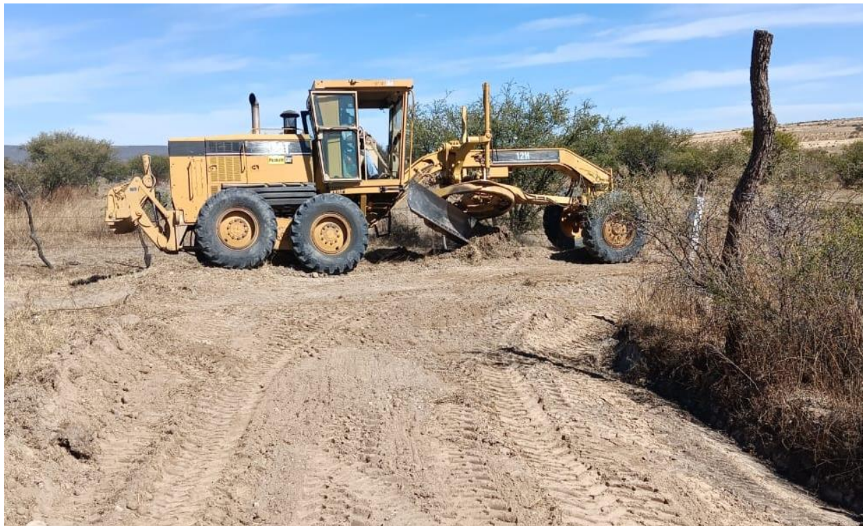
Imagen 3 “Rehabilitación de camino a la Cañada”
