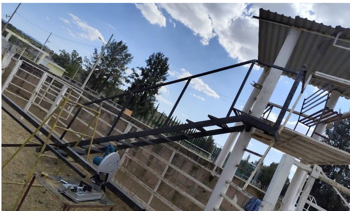
Imagen 18.5 “Instalación de escalera en la cabina.”
