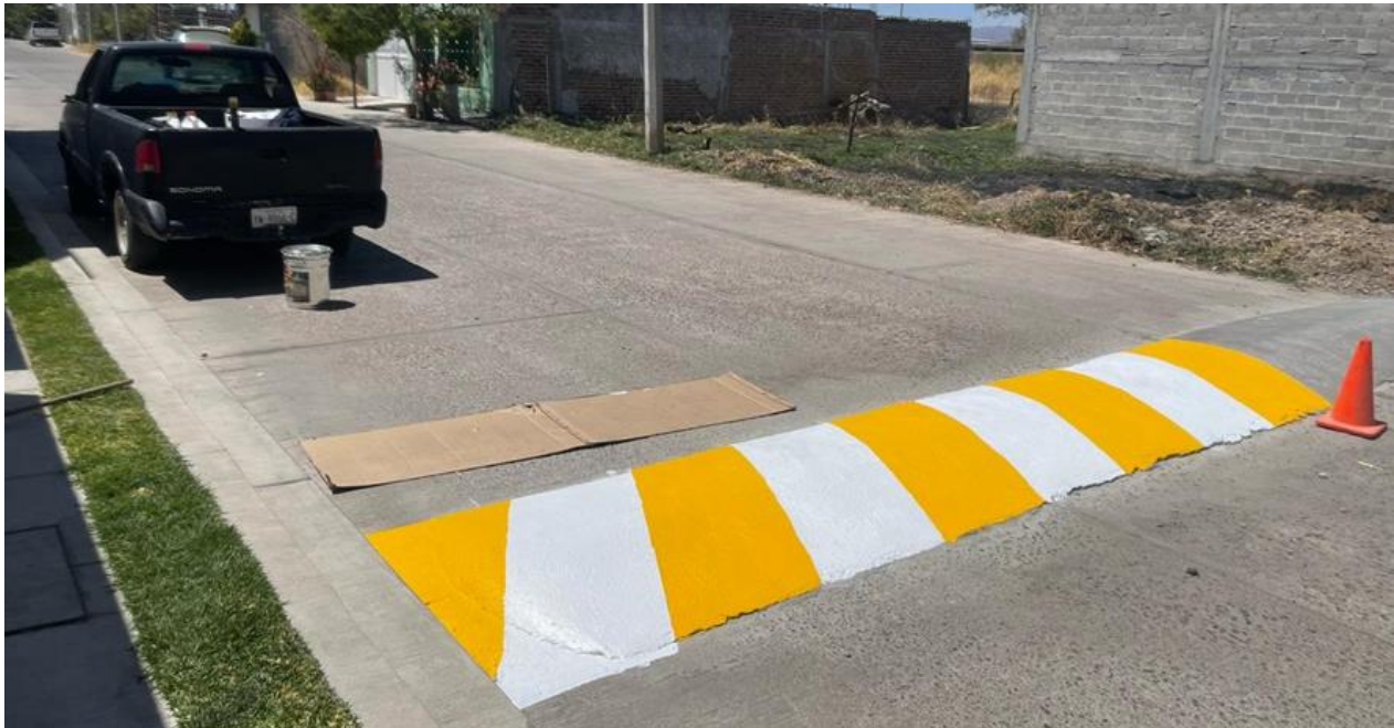
Imagen 4 "Instalación de tope y aplicación de pintura en el fraccionamiento "San Mateo"
