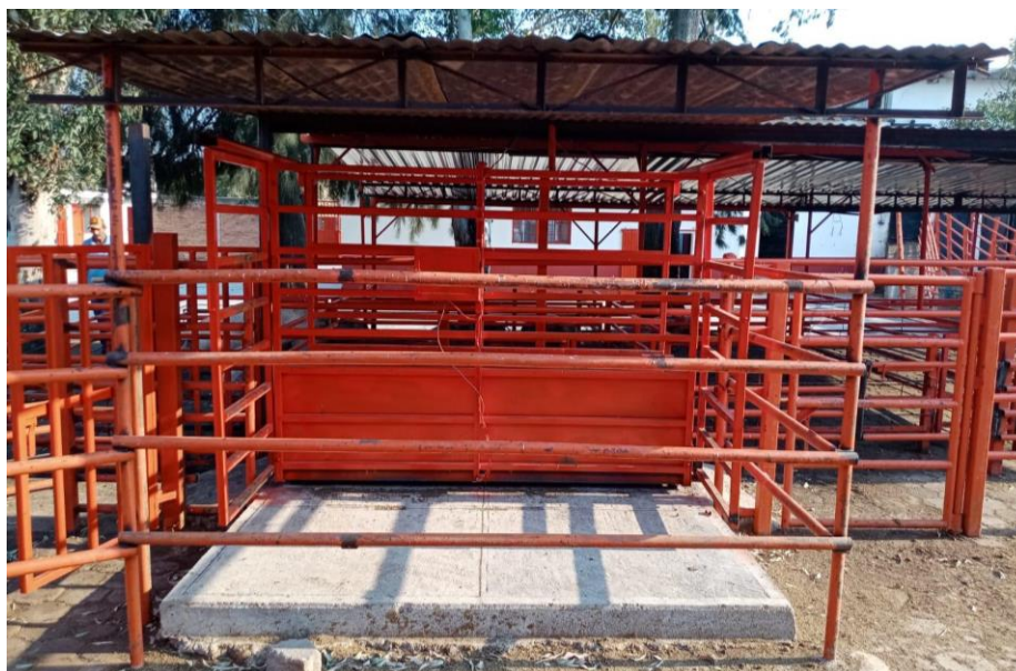
Imagen 17.1 "Instalación de tejaban en corrales del rastro municipal."
