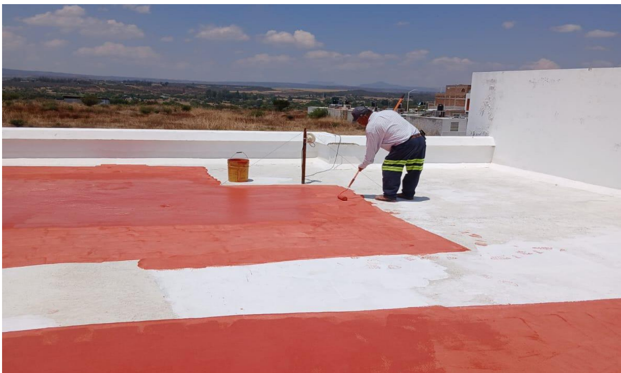
Imagen 18 "Impermeabilización de techos"
