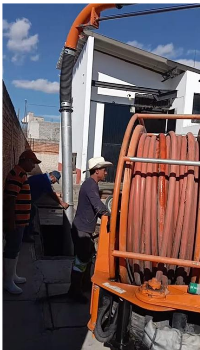
Imagen 13.4 y 13.5 "Mantenimiento a fosa séptica del rastro municipal con camión "Vector"
