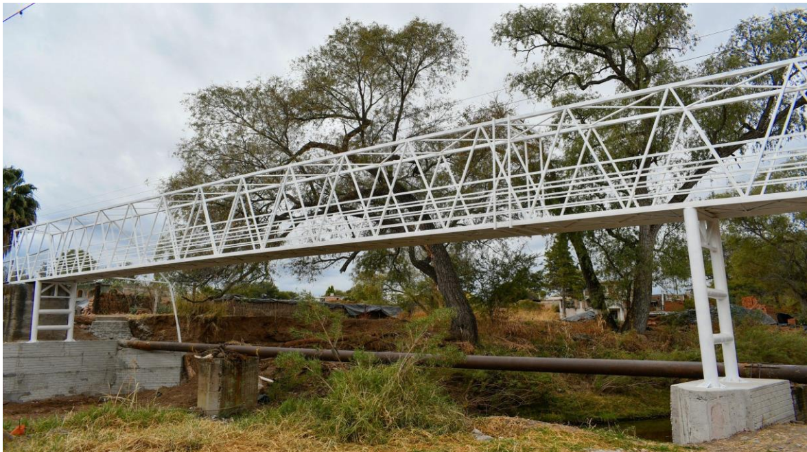
Imagen 5 “Entrega de Obra del puente en el Terrero”
