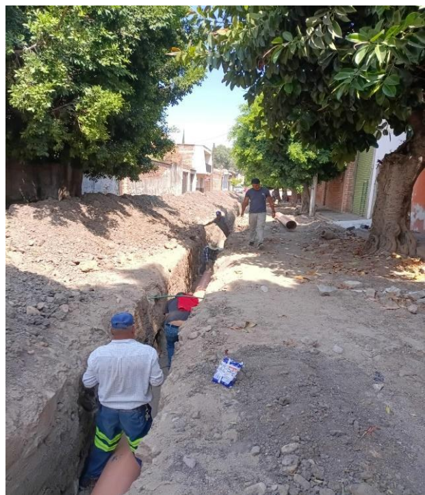
Imagen 13 y 13.1 "Instalación de tubería de 8" para drenaje en calle Abasolo "
