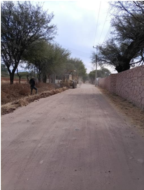
Imagen 3.2 “Rehabilitación de camino en La Villita”
