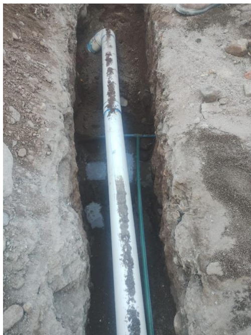
Imagen 11 y 11.1 "Reparaciones de fugas de agua potable municipal"
