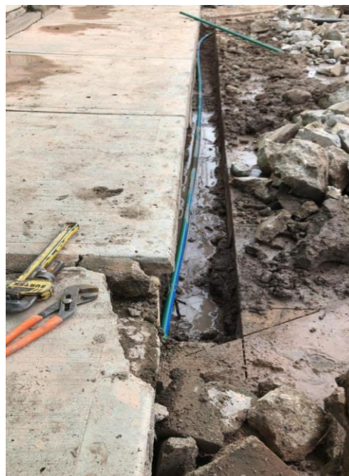
Imagen 11 y 11.1 "Reparaciones de fugas de agua potable municipal"
